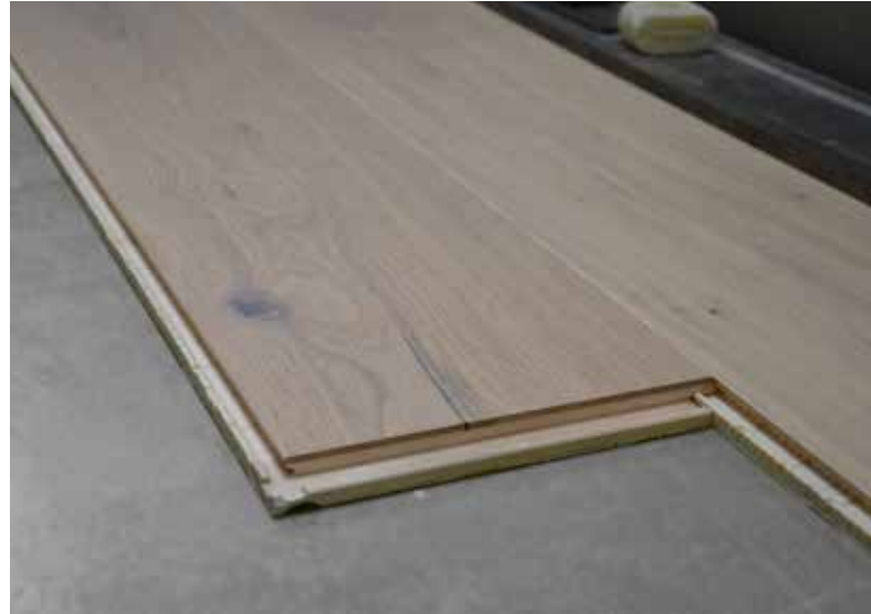
Perfekte Qualität ohne Ausrisse, Hobelschläge oder gequetschte Fasern
