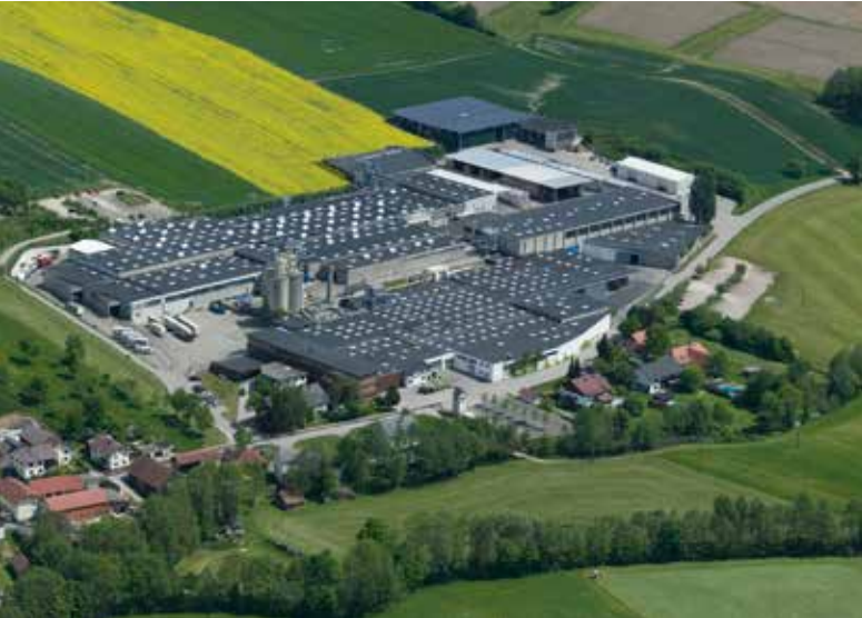
Im oberösterreichischen Lohsburg werden von Tilo anspruchsvolle Bodenlösungen hergestellt
